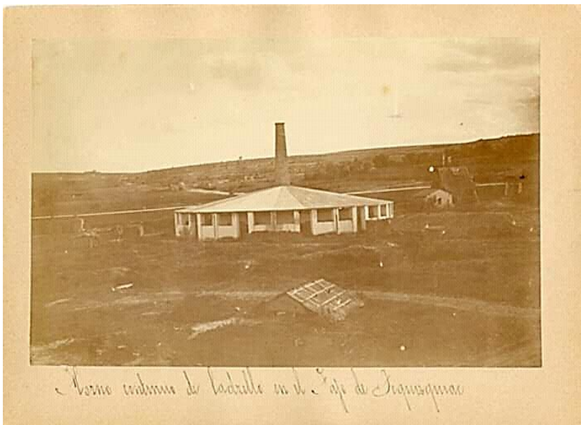
Ilustración 10. El horno de ladrillo de producción continua de Tequixquiac. El sistema de producción denominado Hoffman era de procedencia alemana. Fotografía cortesía de Gerardo García, cronista de Tequixquiac.
