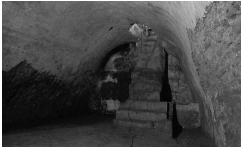
Figura 18. Vista de la cripta, los muros este y oeste evidencian mutilación en sus revestimientos, posiblemente adosados a estos eran ubicados los barriles de vino durante su proceso de estabilización (Cortesía CNPAG).
