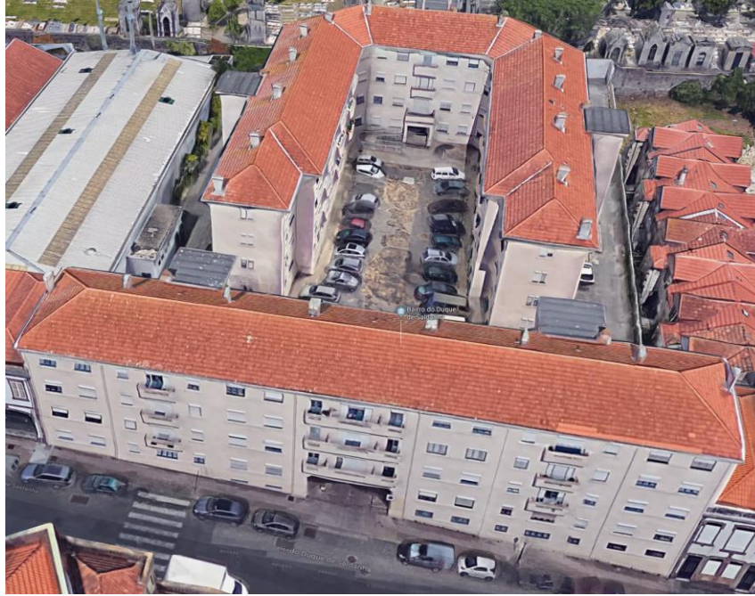
Fig. 10. Vista aérea do Bloco Duque de Saldanha na actualidade. Fonte: Google maps.
