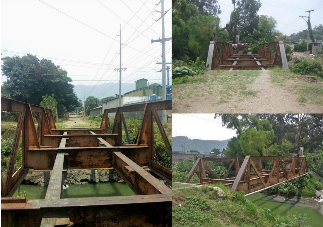
Figura 8. Puente del río Michatoya, cerca de la estación del tren de Amatitlán. Fotografías: Javier Chaluleu, 2019.
