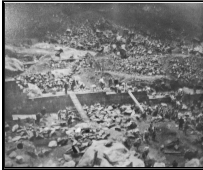
Imagen 4 Avances en la construcción del dique de la Hidroeléctrica Santa María de Jesús, en 1924 (Tomado del Museo del Ferrocarril de los Altos, Quetzaltenango).
