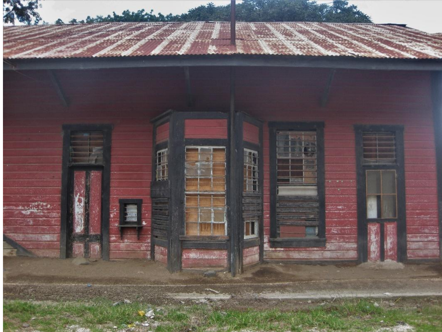
Anexo 2. Estado actual de la taquilla. Fotografía: Javier Chaluleu, 2018.
