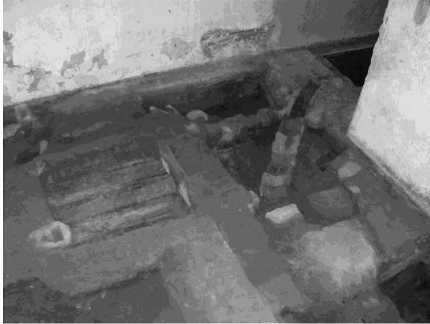
Figura 6. Vista general del cimientado de una hornilla de doble rejilla donde posiblemente se ubicó un horno de caldera de la fábrica de vino de principios del siglo XX, localizado en el ambiente 2 (Operación STR2-2) (Cortesía CNPAG).
