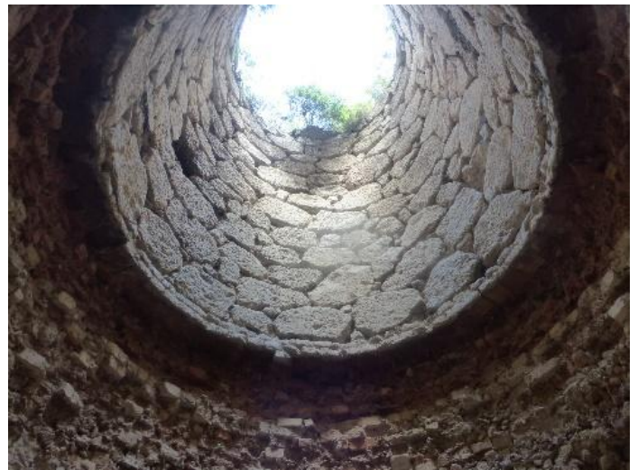
Ilustración 6 y 7: Aspecto externo e interno (el tiro de cocción) del horno de cal El Refugio III objeto del presente trabajo
