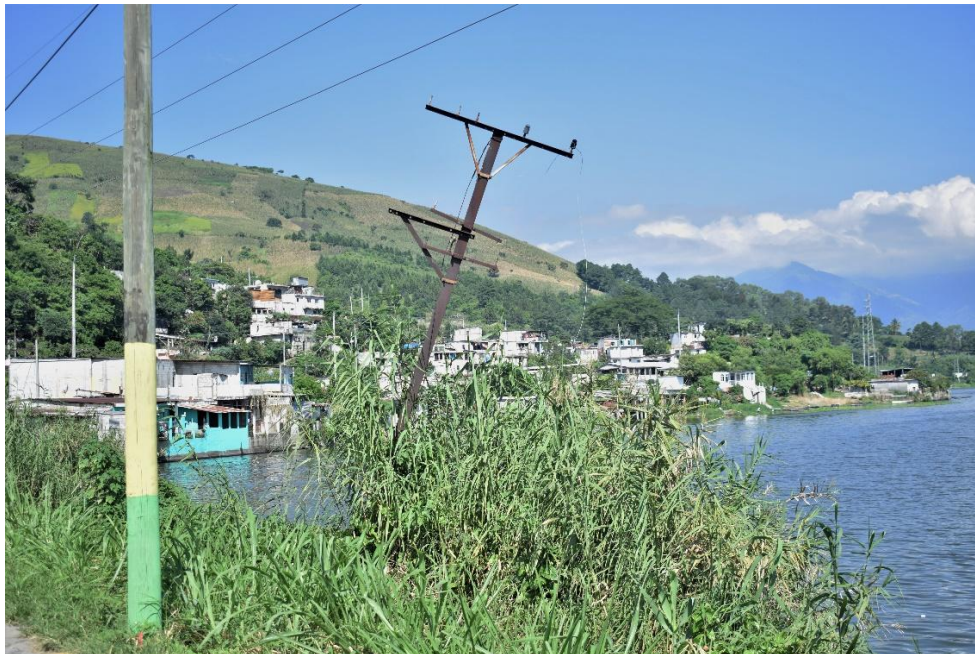
Anexo 5. Poste telegráfico en El Relleno. Fotografía: Javier Chaluleu, 2019.
