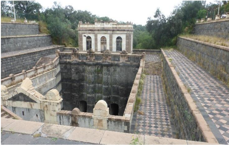
Ilustración 4. La caja de agua de Zumpango. Obra central del sistema de desagüe de la Ciudad de México. Fue inaugurada el año de 1900.
