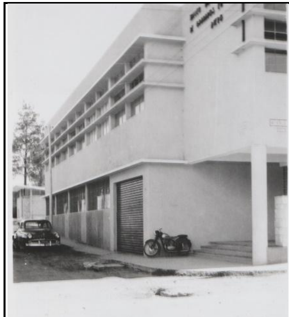
Fotografía 2. Vista del Edificio del Taller Nacional de Grabados en Acero en 1960 Cortesía Familia Chávez Peraza 2019
