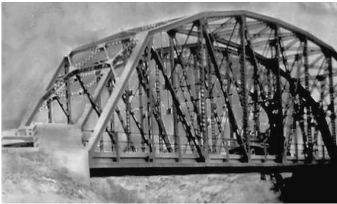
Ilustración 1. El Puente de Fierro de Ecatepec, México. Antigua fotografía donde se observa que existían dos estructuras para las vialidades. Actualmente sólo existe uno de ellos.
