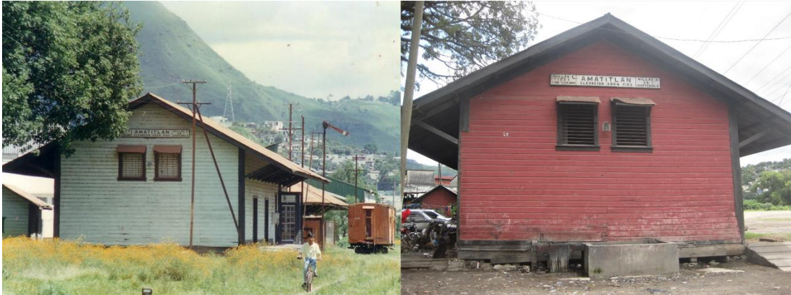
Figura 6. Izquierda: estación de tren de color blanco, aún se observa un vagón. Fotografía: Edgar Carpio, 1996. Derecha: estado actual de la estación de color rojo. Fotografía: Javier Chaluleu, 2018.
